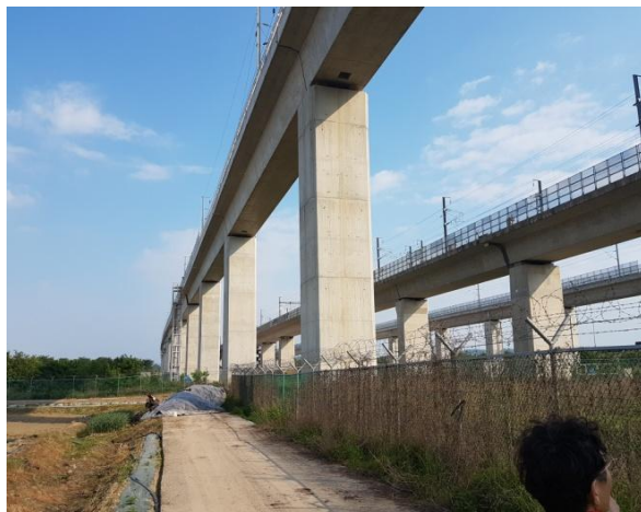
교량 측면 전경
